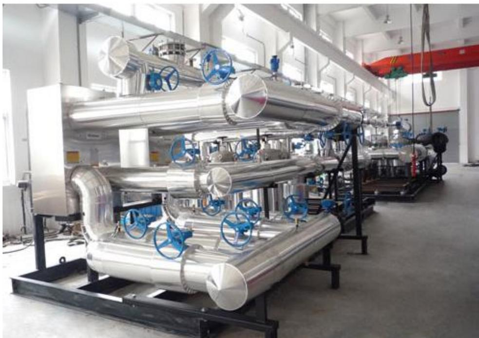
De manière équivalente, une sous-station de froid joue exactement le même rôle entre le réseau de froid urbain (réseau primaire) et le circuit de climatisation des locaux (réseau secondaire).
