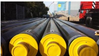
Le réseau souterrain de canalisations est réalisé en acier avec isolation renforcée en mousse polyuréthane. Les canalisations sont enterrées sous domaine public sur un lit de sable.
