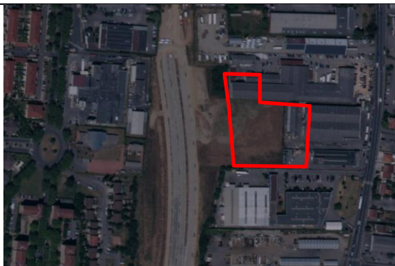
Photographie aérienne du site en juin 2014 – travaux de construction du boulevard des Droits de l'Homme en cours
